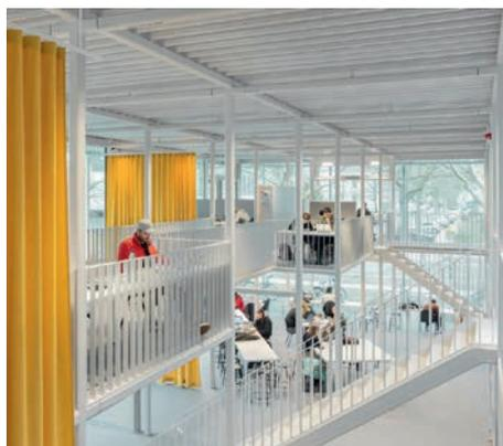
finden. Die vollverglaste Fassade sorgt für eine hervorragende Tageslichtqualität in allen Bereichen und verbindet Innen- und Außenbereiche nahtlos miteinander. Schallabsorbierende Vorhänge, Teppichböden und Akustikdecken sorgen für eine gute Raumakustik, die eine angenehme Gesprächsatmosphäre ermöglicht. Das Gebäude wurde mit dem Deutschen Architekturpreis 2023, dem EU Mies van der Rohe Award 2024 und dem DAM Preis 2024 ausgezeichnet.
