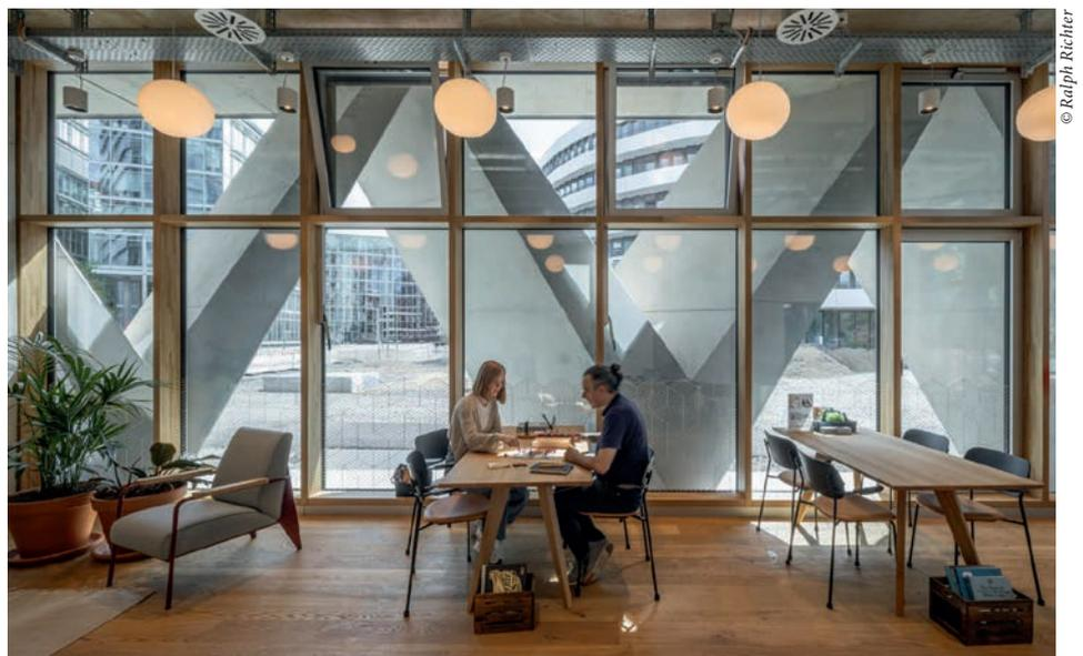
Loggien. Weiterhin ist sie Ausdruck der Kreislauffähigkeit, denn die elementierten V-Stützen aus Lärchenholz folgen dem Konzept „Design für Disassembly“. Insgesamt wurden 2.150 m<sup>3</sup> Holz aus zertifiziert nachhaltiger europäischer, größtenteils deutscher Forstwirtschaft verbaut. Holz als nachwachsendes Material ersetzt, wo
